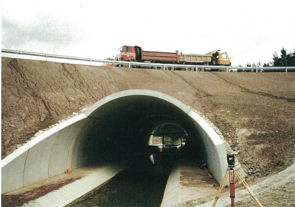
Zátěžová zkouška Nýřany - objekt 205 (most přes Vejprnický potok)
