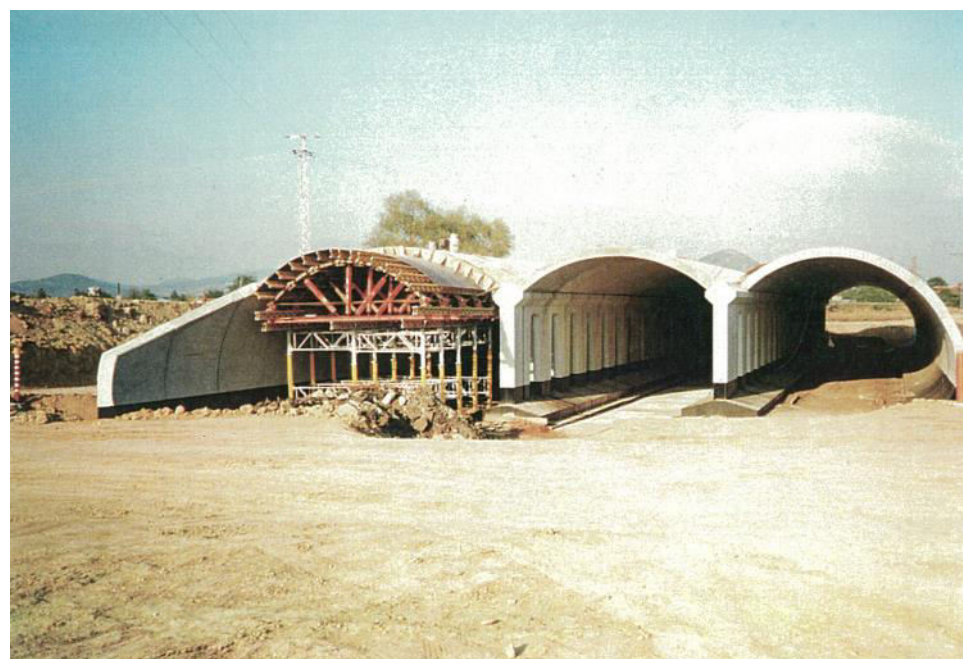
Dálniční most přes Modlu - objekt 218
