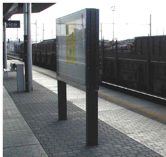
Obr. 9: Stojany informačního systému, vlevo správné řešení se zarážkou pro slepeckou hůl
