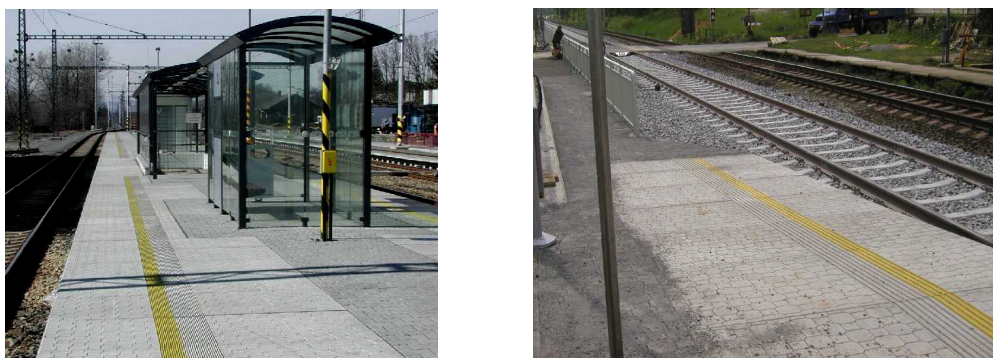
Obr. 14: Rozestavěná nástupiště s hmatovými úpravami pro nevidomé a slabozraké
