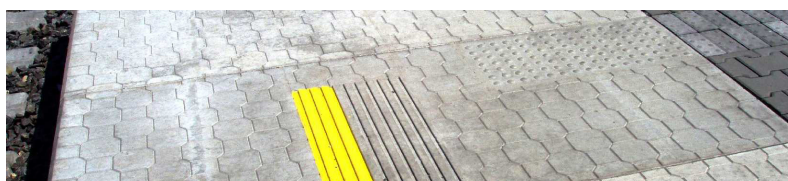
Obr.12 - Konec nástupiště s osazenou novou konzolovou deskou délky 2300 mm
