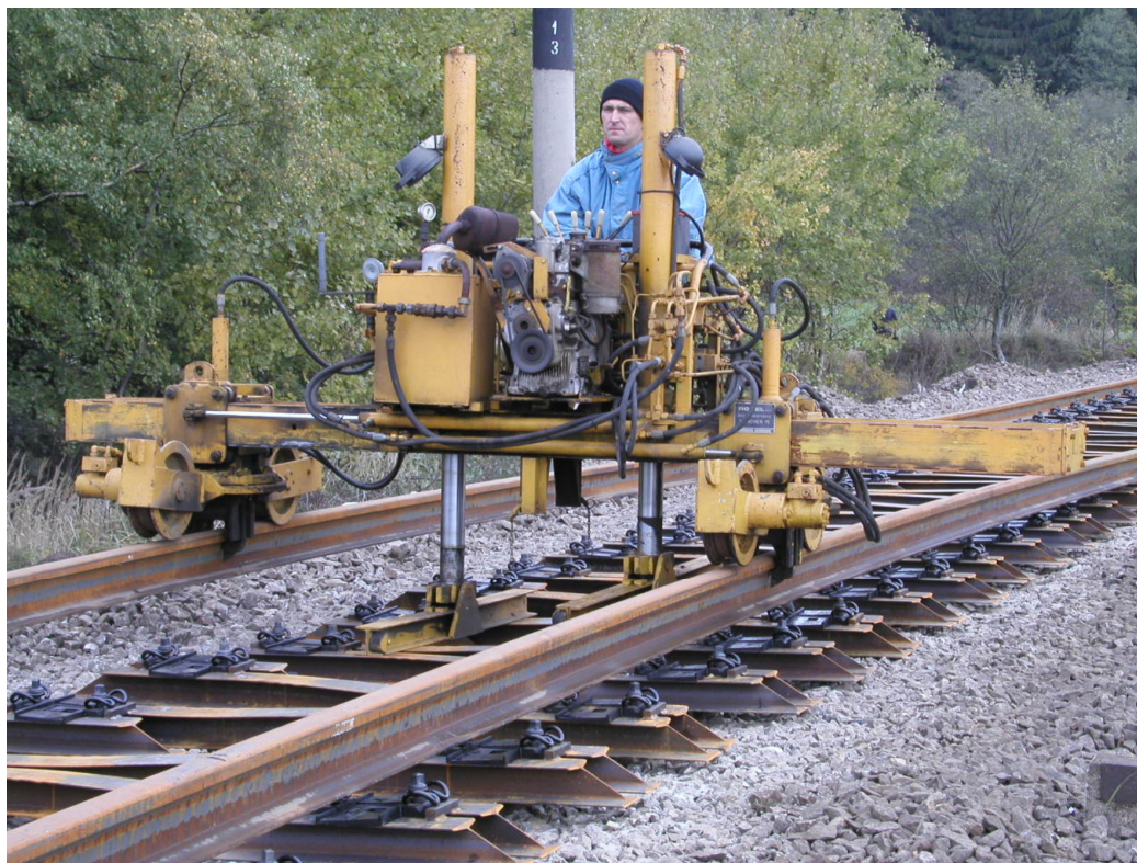
Obr. 8 - pokládka kolejnic strojem Robel
