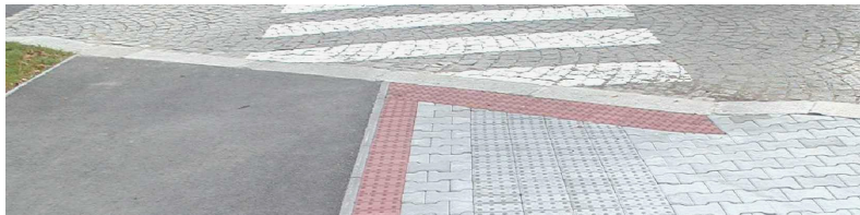
Obr.2 - Hmatný pás vyznačuje hranici nebezpečného prostoru, místo vstupu na cyklistickou stezku.
