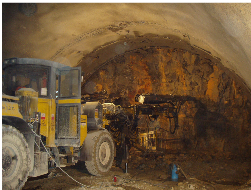
Tunel Krasíkov 1 – provizorní vstrojení
