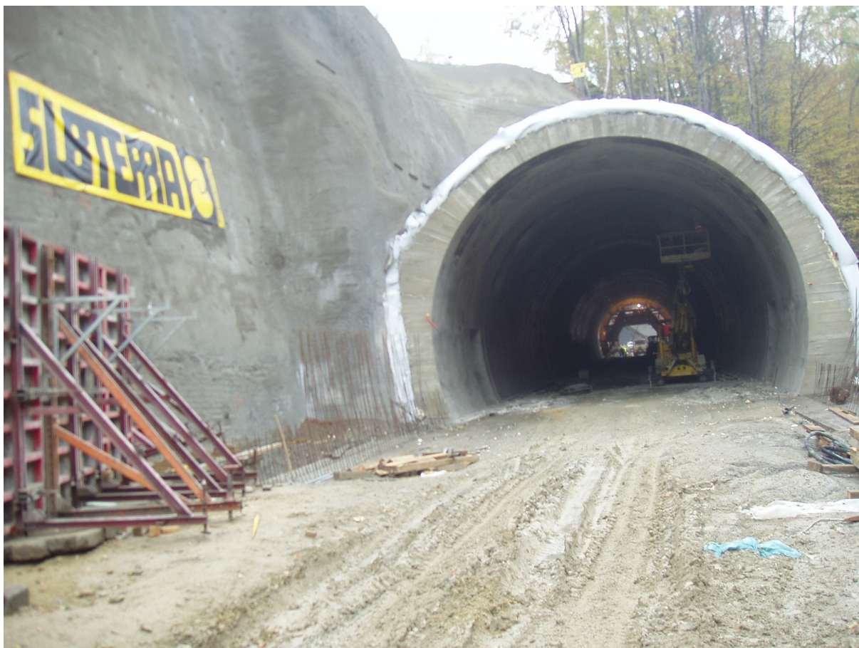
Tunel Krasíkov 2 - pohled z portálu P2 na definitivní obezdívku
