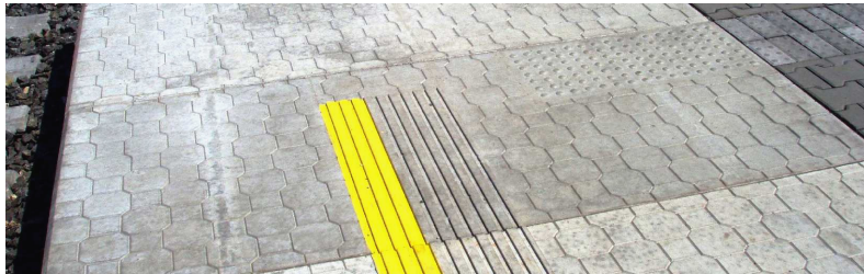
Obr.3 - Varovný pás (s výstupky) hmatově vyznačuje hranici nepřístupného prostoru na nástupišti .
