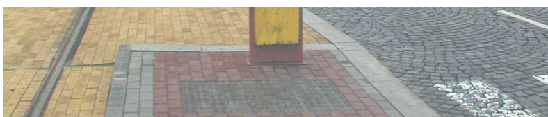
Obr.5 - Signální pás na zastávce tramvaji označuje orientačně zajímavé místo (nástup do vozidla).
