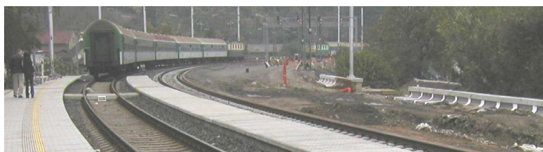
Obr.8 - Varovný pás sloučený s vodící linií na vnějším železničním nástupišti.
