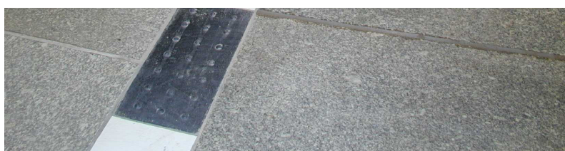
Obr.9 - Detail varovného pásu na nástupišti metra.
