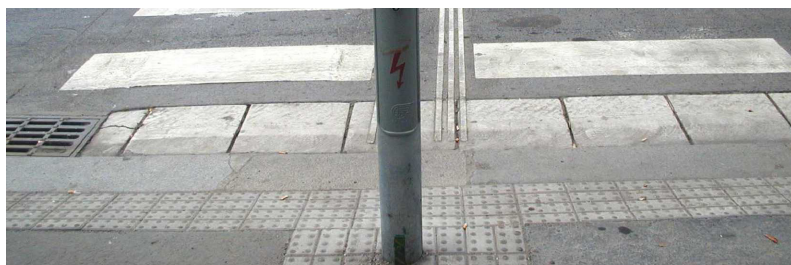
Obr.7 - Vodící pás přechodu pomáhá na složitých přechodech nevidomému udržet správný směr chůze.
