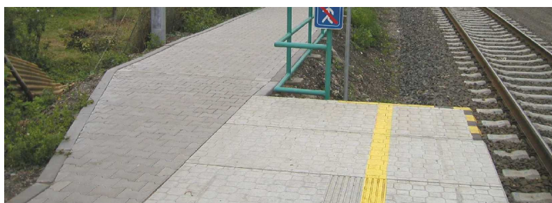
Obr.10 - Úpravy na vnějším nástupišti, při pohybu podél zábradlí se nevidomý dostává k mezeře, která není hmatově vyznačena. Může proto projít až k hraně nástupiště a ocitá se v nebezpečné situaci
