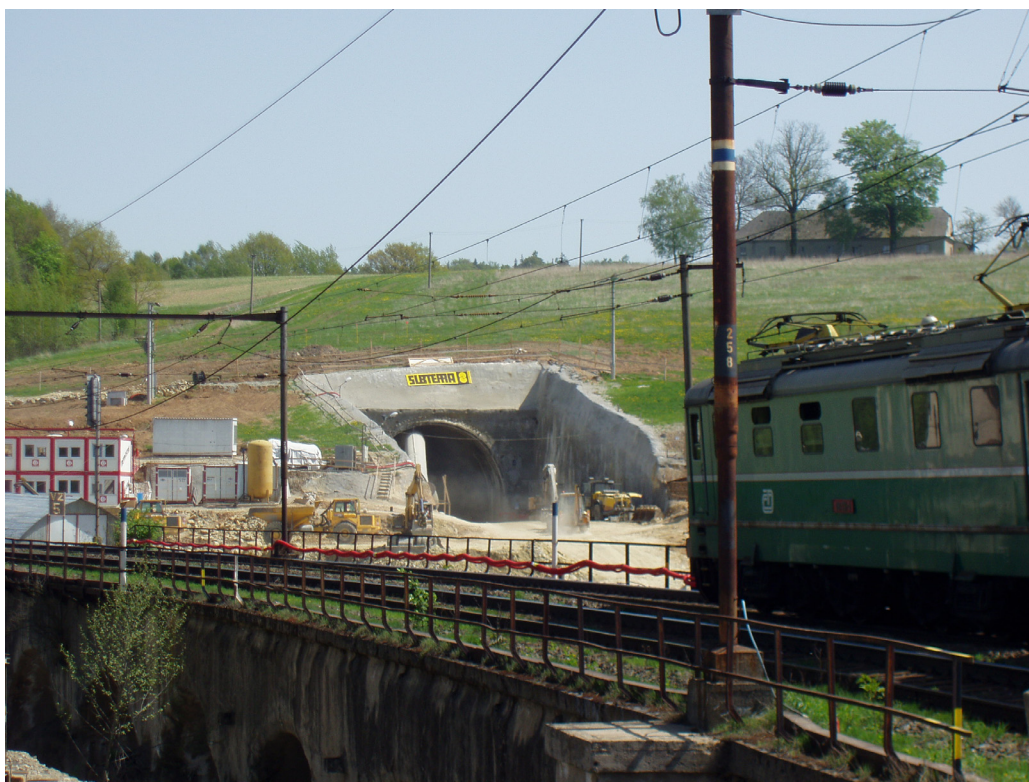
Tunel Krasíkov 1 – ústí portálu P1
