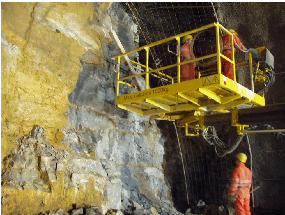
Tunel Krasíkov 1 – vrtání čelby kaloty
