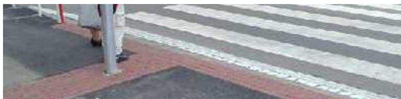
Obr.1 - Varovný pás hmatově vyznačuje hranici nebezpečného prostoru, místo vstupu do vozovky.
