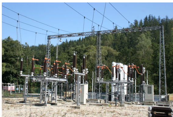
Rekonstrukce napájecí stanice Hoštejn
