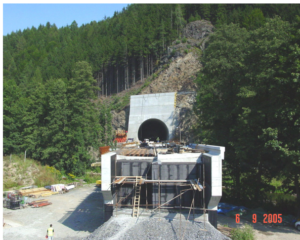
Obr. 4 - Zabetonovaný výjezdový portál tunelu Hněvkovský II
