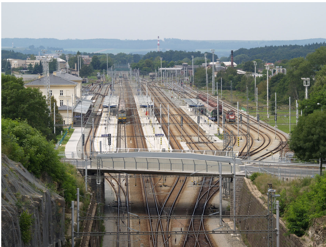
Obr. 1 - celkový pohled na zrekonstruovanou ŽST Choceň - krátce po uvedení stavby do provozu
