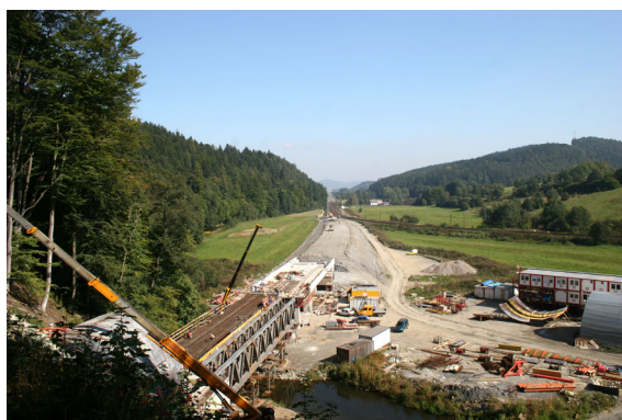
Vyústění tunelu Hněvkovský II směrem k Zábřehu
