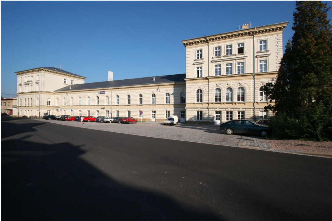
Obr. 3 - citlivě zrekonstruovaná novorenesanční fasáda výpravní budovy při pohledu z uliční fronty
