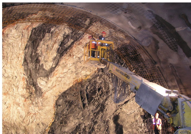
Obr. 6 - Ražba Jižního Vítkovského tunelu
