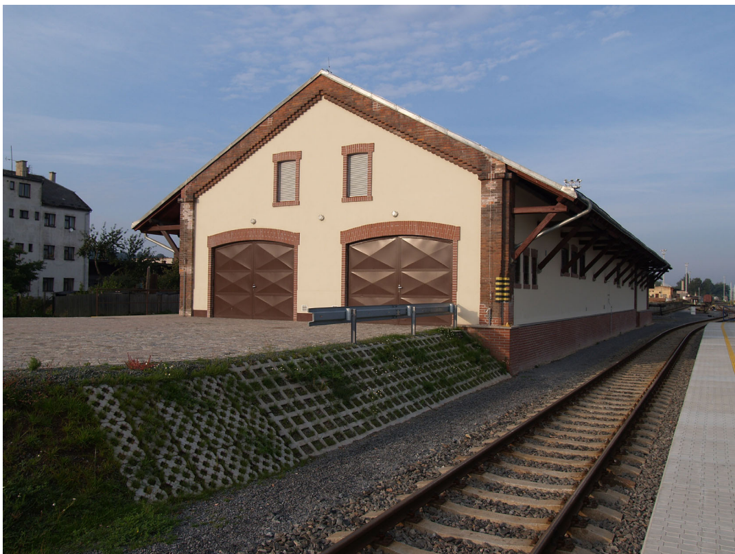
Obr. 4 - bývalé staniční skladiště adaptované na technologickou budovu pro elektronické stavědlo
