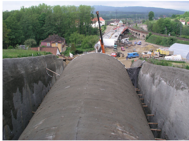
Obr. 2 - Primární ostění na hloubeném úseku
