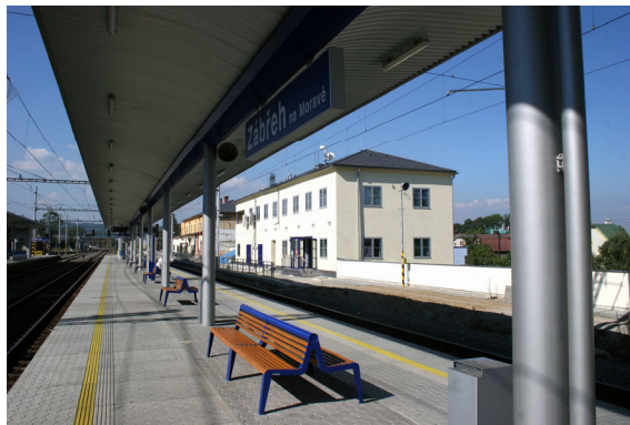
Železniční stanice Zábřeh
