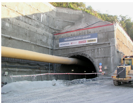
Obr. 5 - Východní portál tunelů Nového spojení
