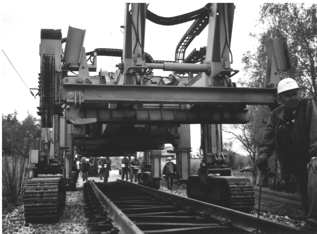
Obr. 3 - Pokládka kolejových polí pokladačem DESEC TL 50 ZSP
