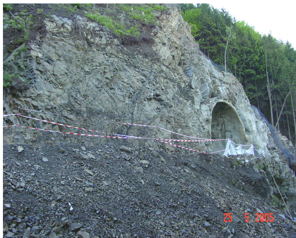
Obr. 3 - Výjezdový hloubený úsek tunelu Hněvkovský II
