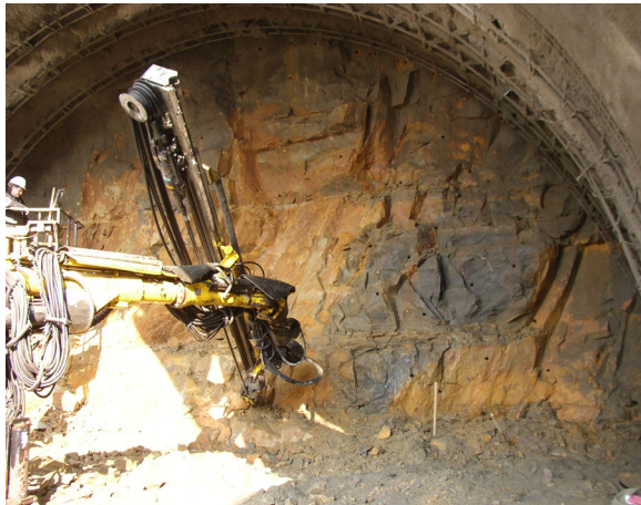
Obr. 1 - Ražba kaloty tunelu Krasíkov
