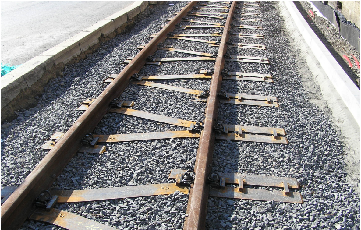
Vratislavice – dokončený úsek
