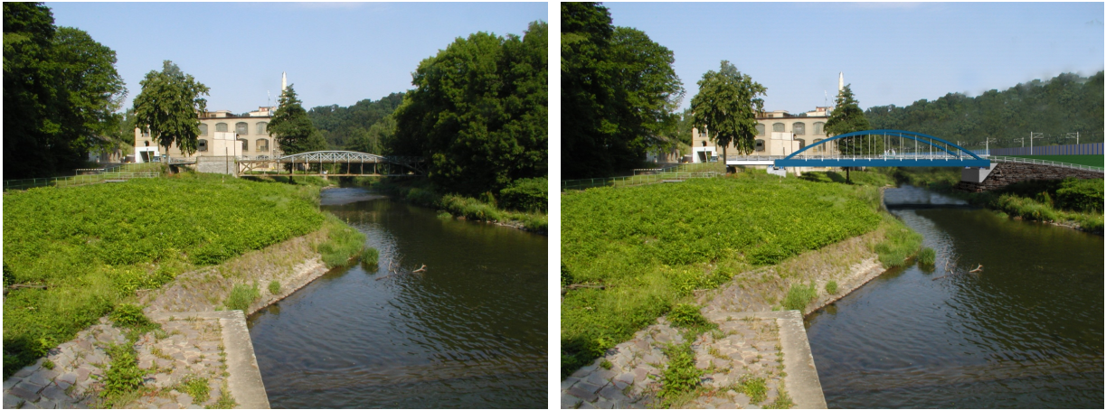
Silniční most přes Tichou Orlici
