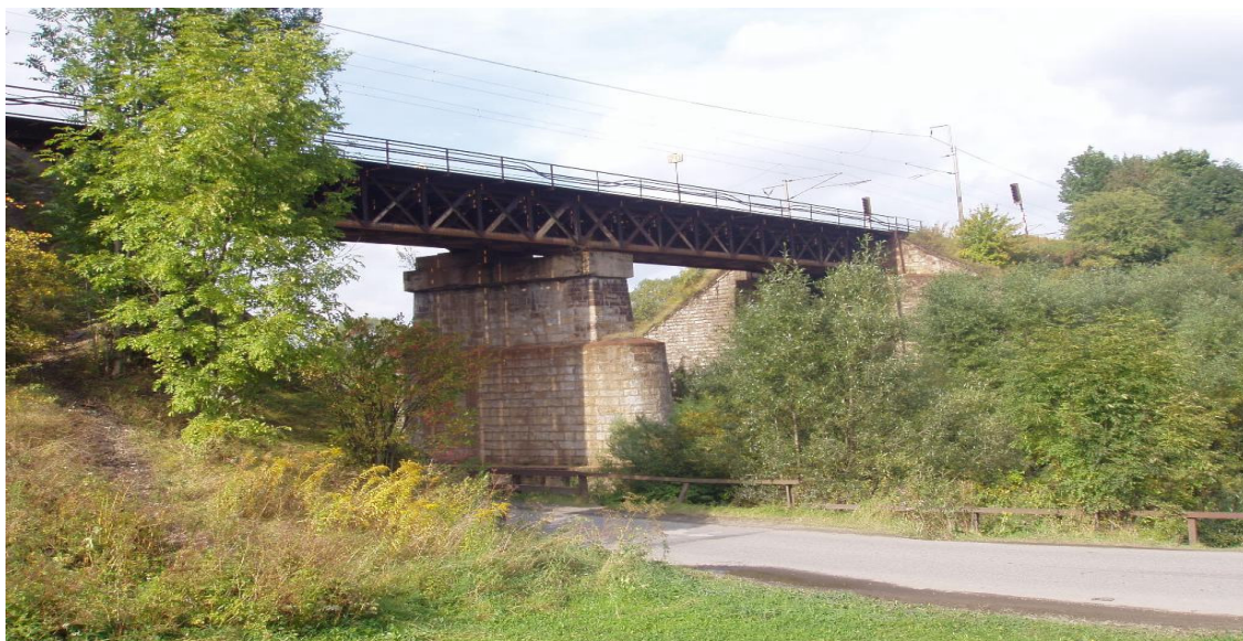
Most v km 297 847 – Fotografie stávajícího stavu
