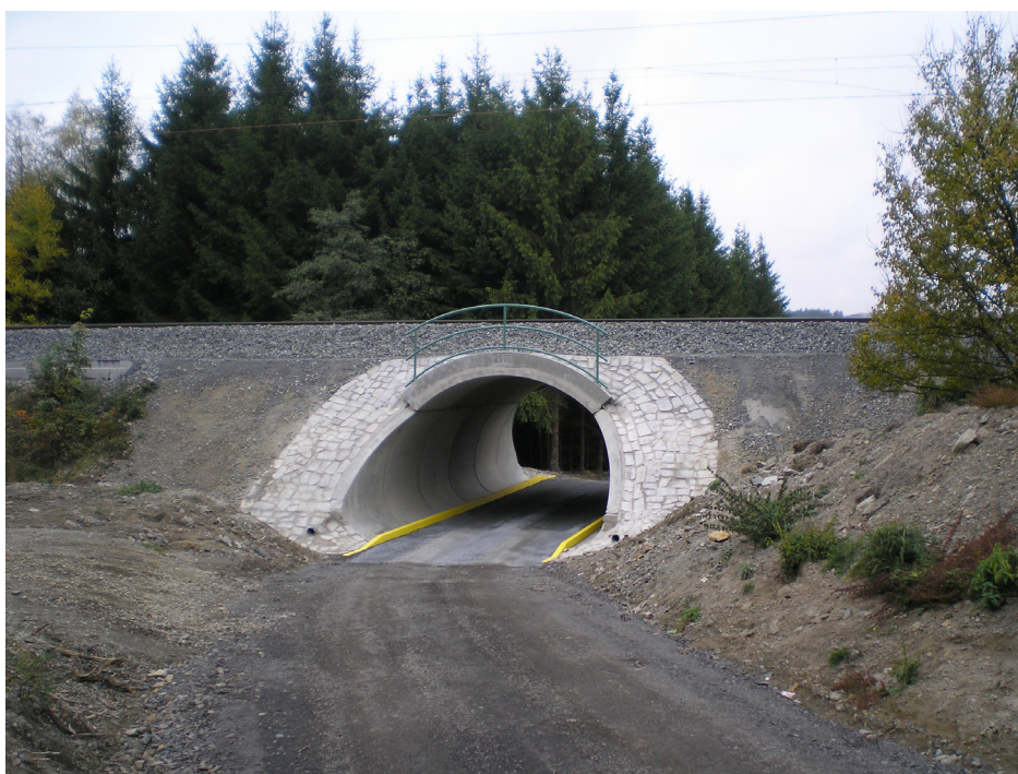
Nový most na jednokolejném úseku Přovany – Vranov (systém Matiere)
