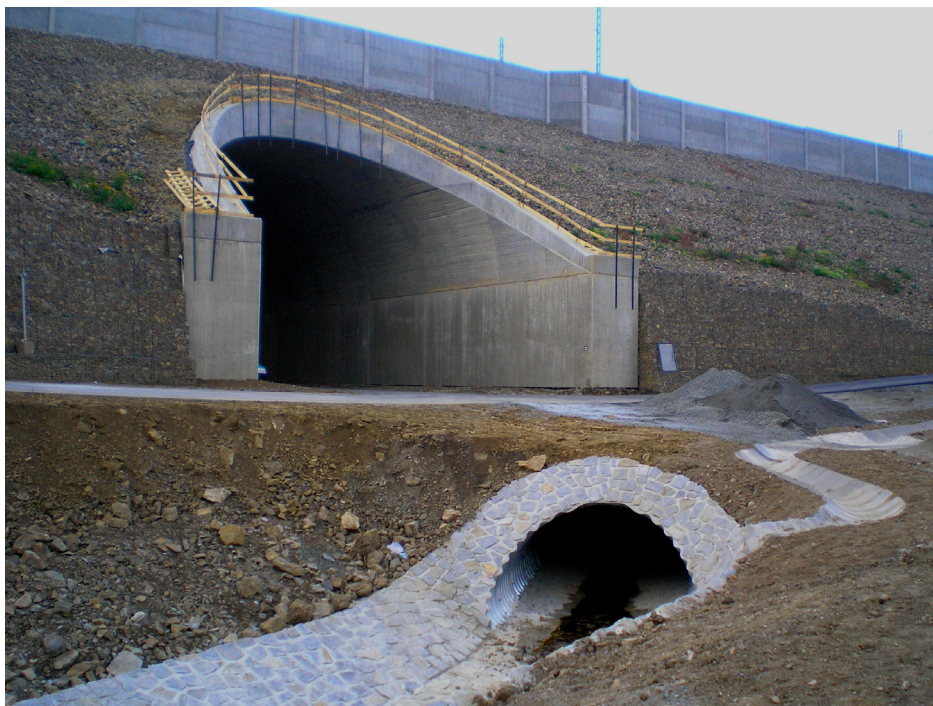
Nový dvukolejný most před Plešnicemi se zatrubněním Úlického potoka nacházejícího pod dnem mostu
