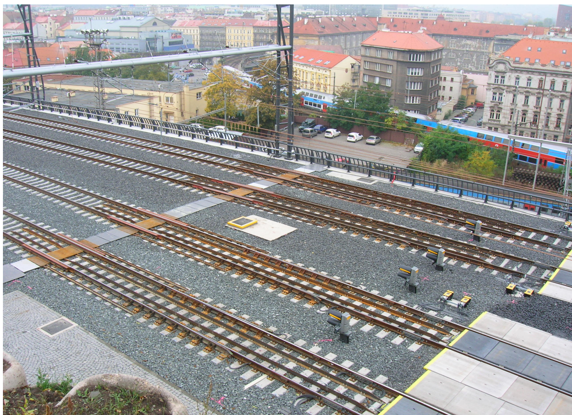
Obrázek 1a – KDZ vložená ve stavbě Nové spojení Praha
