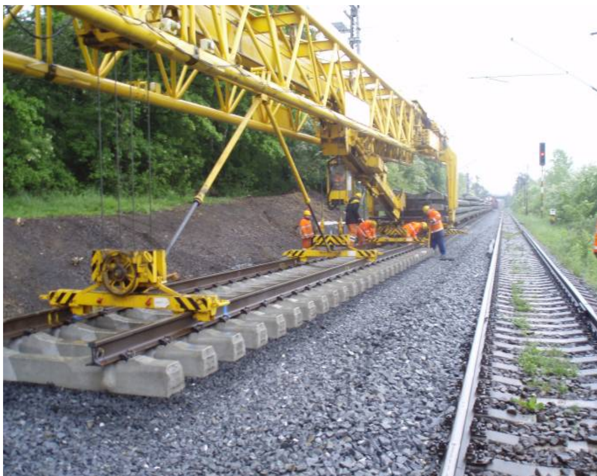
Pokládka kolejových polí na úseku 15 pomocí PKP 25/20i (foto: Subterra a.s.)
