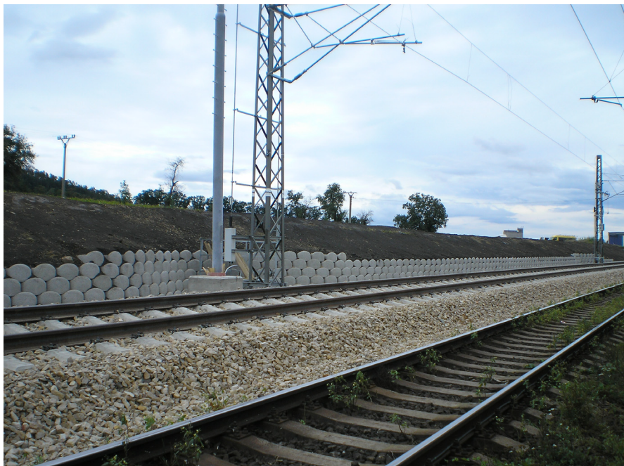
Stavba Optimalizace trati Beroun – Zbiroh
