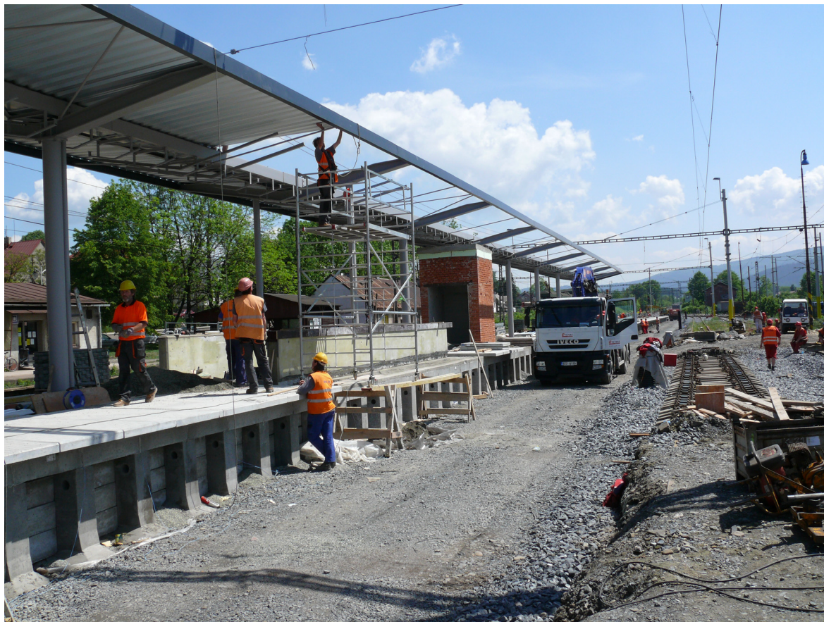
Práce na nástupišti v žst. Jablunkov-Návsí (foto: Subterra a.s.)
