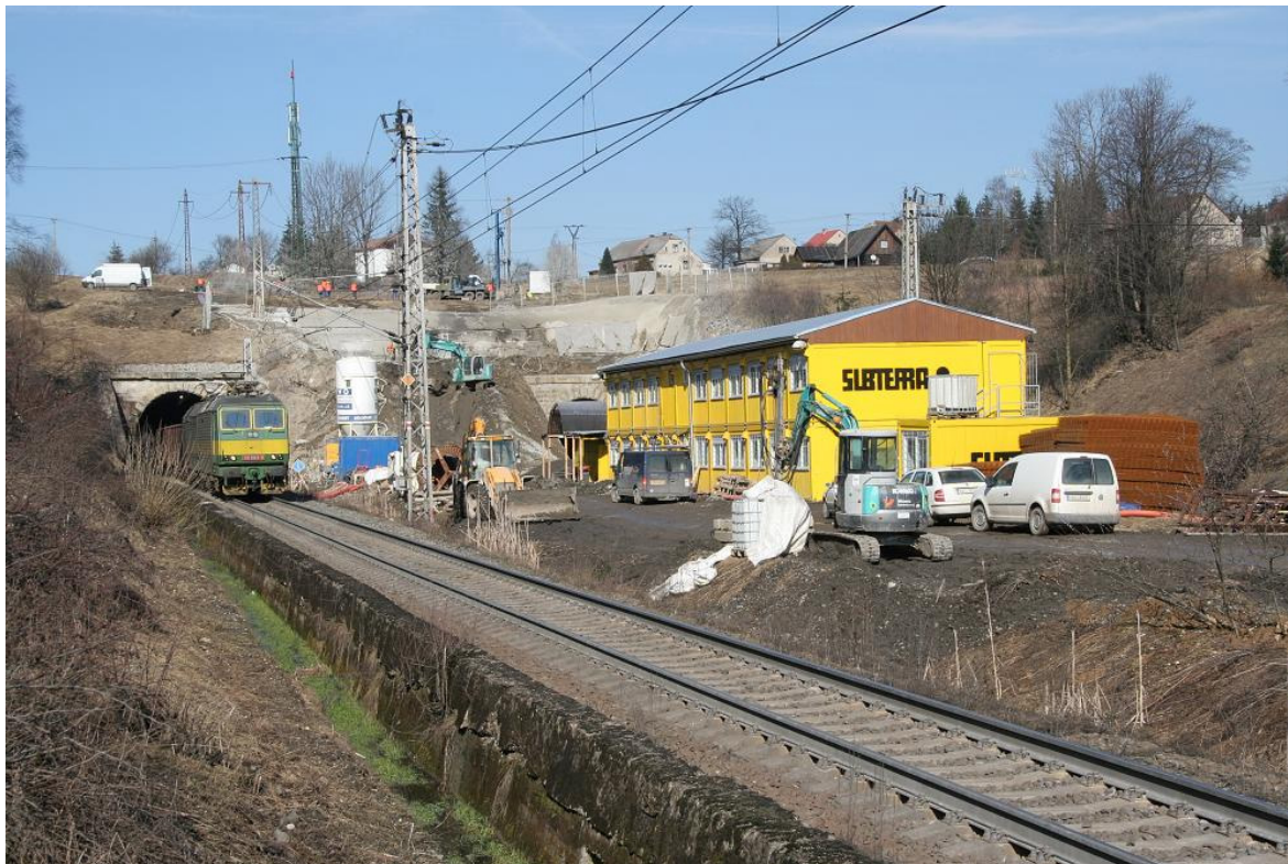
Pohled na zařízení staveniště Jablunkovských tunelů od slovenských hranic (foto: Subterra a.s.).
