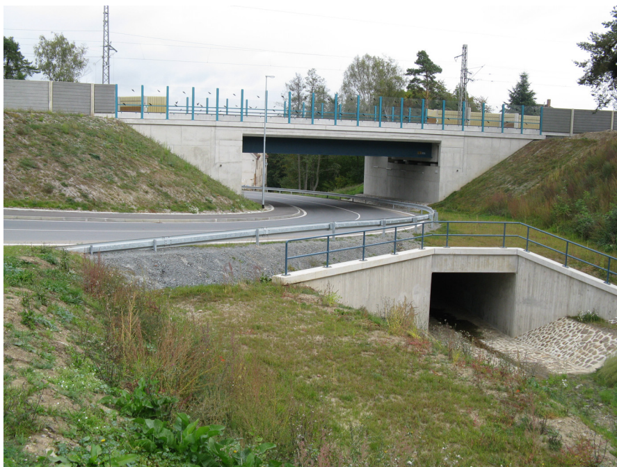
Stavba Optimalizace trati Stříbro – Planá u Mariánských Lázní
