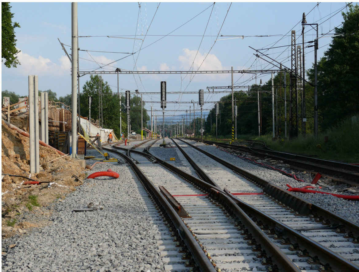
Vjezd do žst. Bystřice nad Olší (foto: Subterra a.s.)
