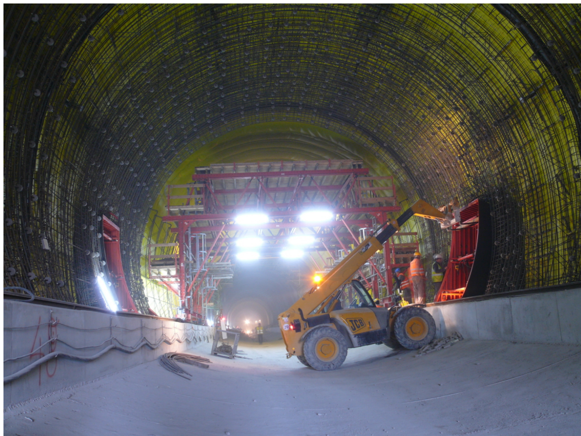
Montáž armatury definitivního ostění tunelu Jablunkovský č. 2 (foto: Subterra a.s.)
