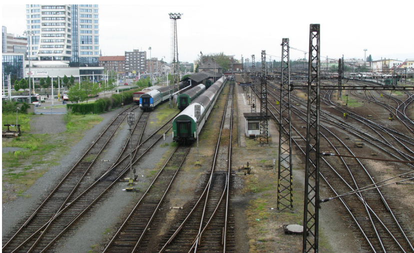
Pohled na stávající kolejiště osobního nádraží
