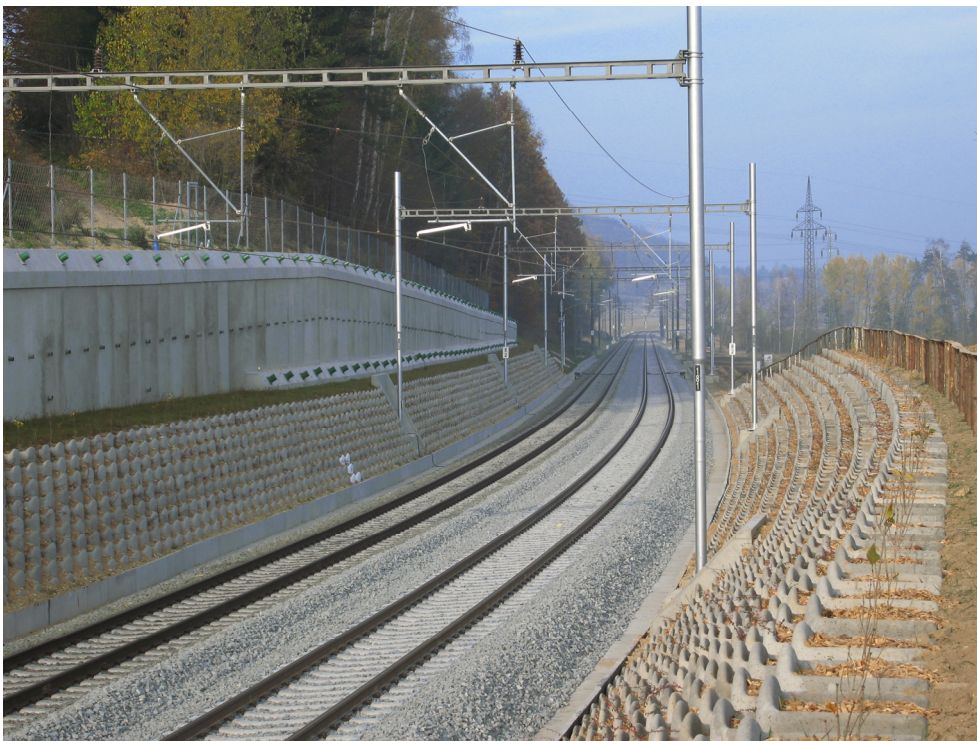
Obr. 2 Pilotová stěna v km 8,000 – 8,250
