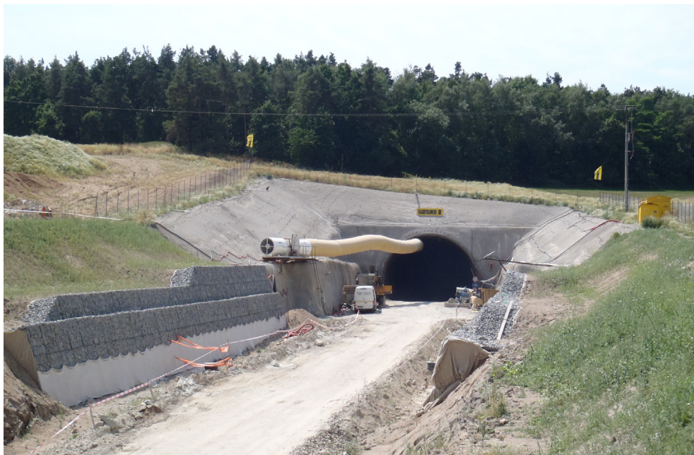
Obr. 2 Portál Zahradnického tunelu
