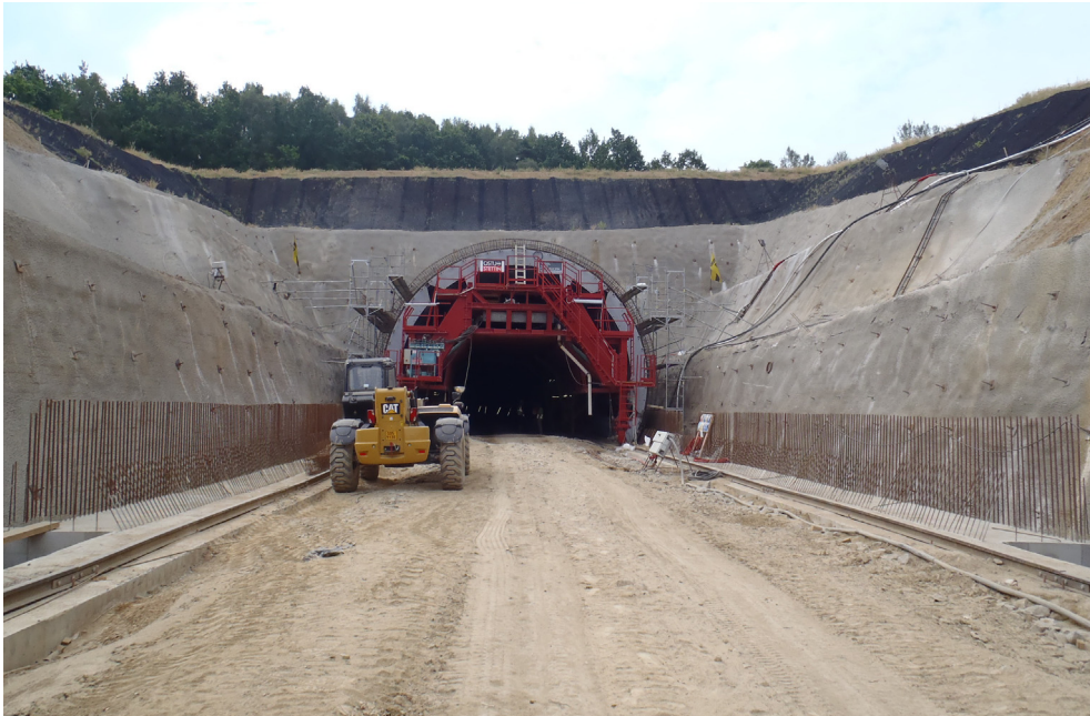
Obr. 1 Portál Olbramovického tunelu
