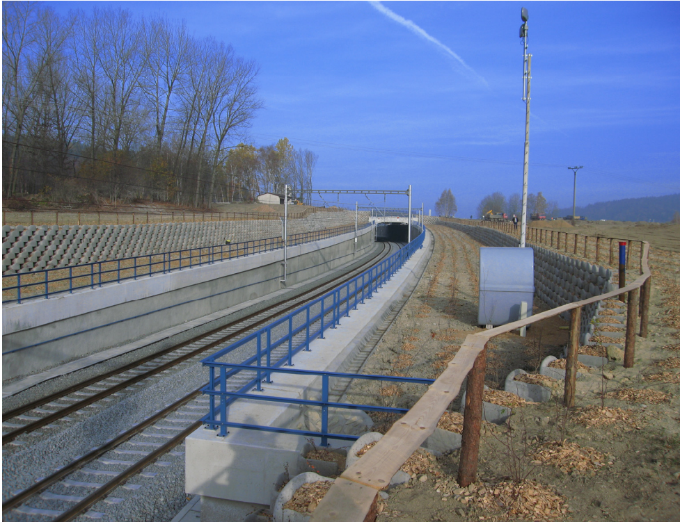
Obr. 1 Pohled na tunel se zajištěným zářezem
