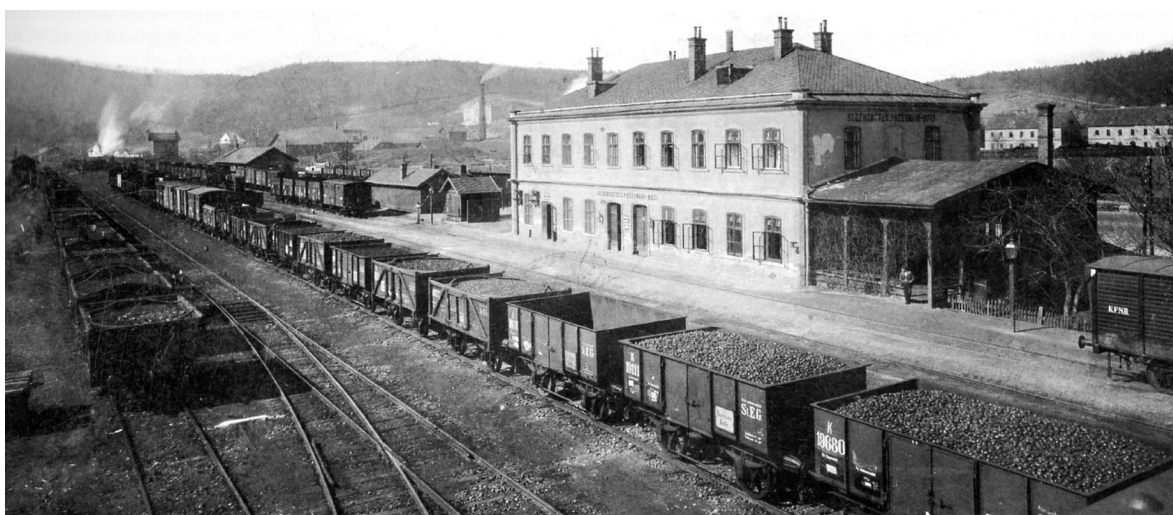
Železniční stanice Zastávka u Brna v období 80. let 19 století; Sběrka VSRO
