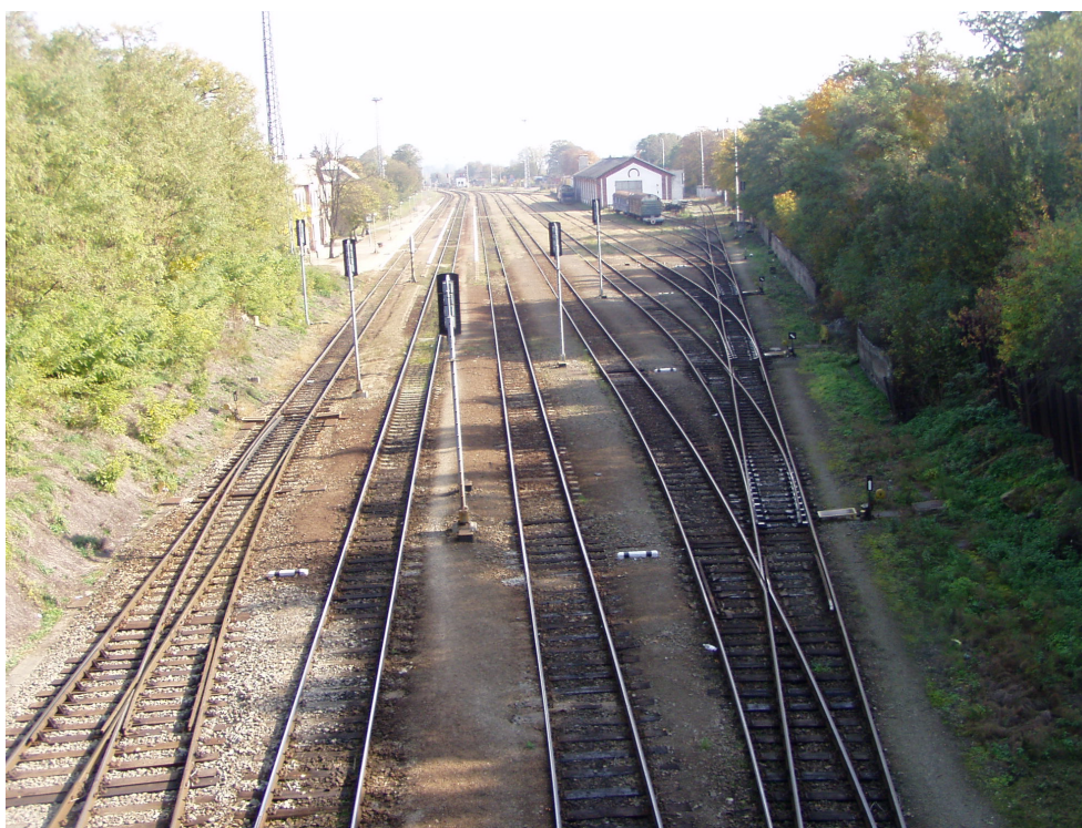
Pohled z nadchodové lávky na žst. Střelice
