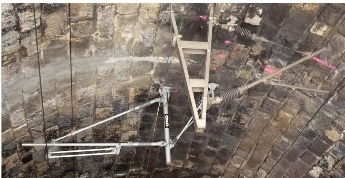
Obr. 6: Nový a starý závěs TV v tunelu
