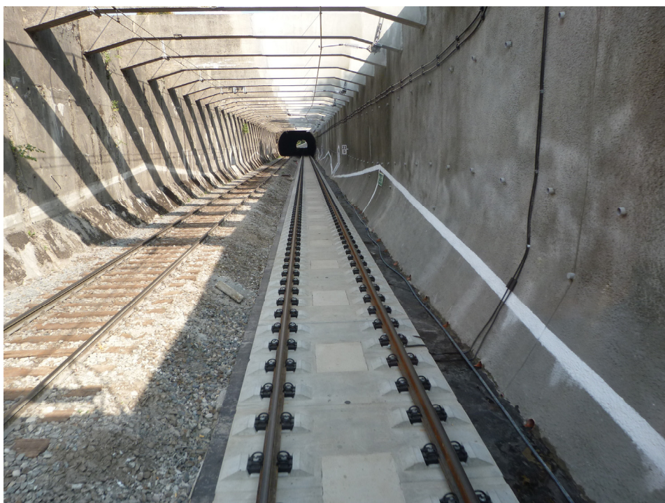
Obr. 1: Pevná jízdní dráha systému ÖBB-PORR v 1. koleji Střelenského tunelu
