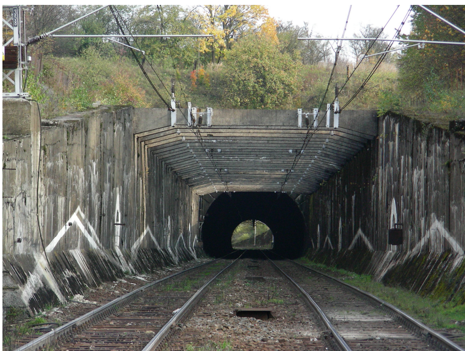
Obr. 1: Pohled na žebra zárubních zdí ze zastávky Střelná směrem do tunelu
