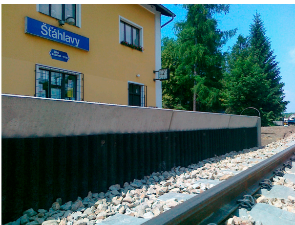
Obr. 6: Protihlukové opatření nástupištní hrany H130
