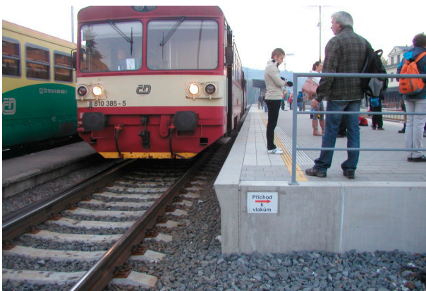
Obr. 5: Prefabrikované dílce nástupišť a jejich ukončení
