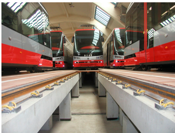
Obr. 4: Prefabrikované nosníky montážních kolejí s pružným upevněním VOSSLOH
