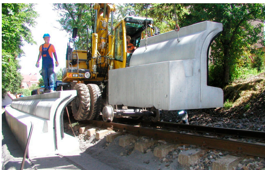
Obr. 13: Montáž NPC
