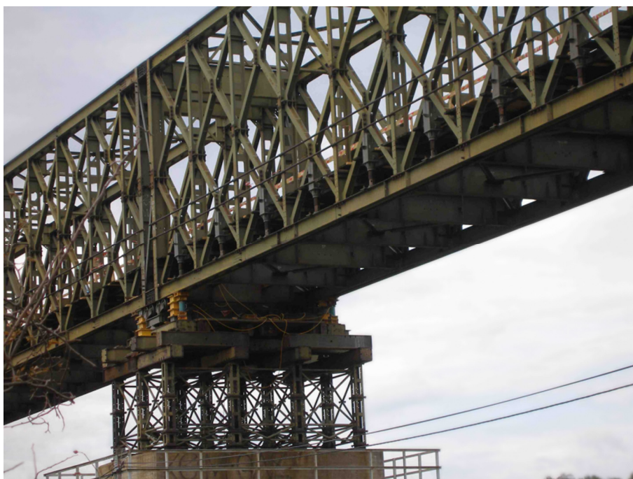
Obr. 2: Železniční trať Šatov – Retz. Dvoupatrový jednostěnný most ŽM-16M na pilíři PIŽMO ve fázi demontáže v roce 2011.
