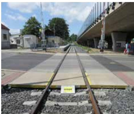
Obr.4 – Železniční přejezd v km 2,278
