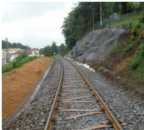
Obr.2 - Odřez v úseku Vesec u Lib. – Jablonec dol. n.
