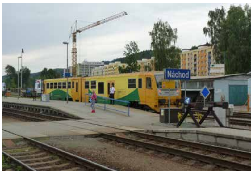
Foto1 – K prvním realizacím se řadí poloostrovní nástupiště v žst. Náchod; ze snímku je patrné provedení přístupové rampy na celou šíři nástupiště, umístění zábradlí uprostřed i zachování ostatních nízkých úroňových nástupišť.
