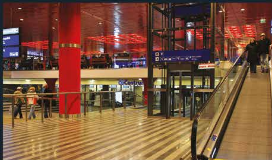
Rekonstrukce odbavovací haly železniční stanice Praha hlavní nadraží
