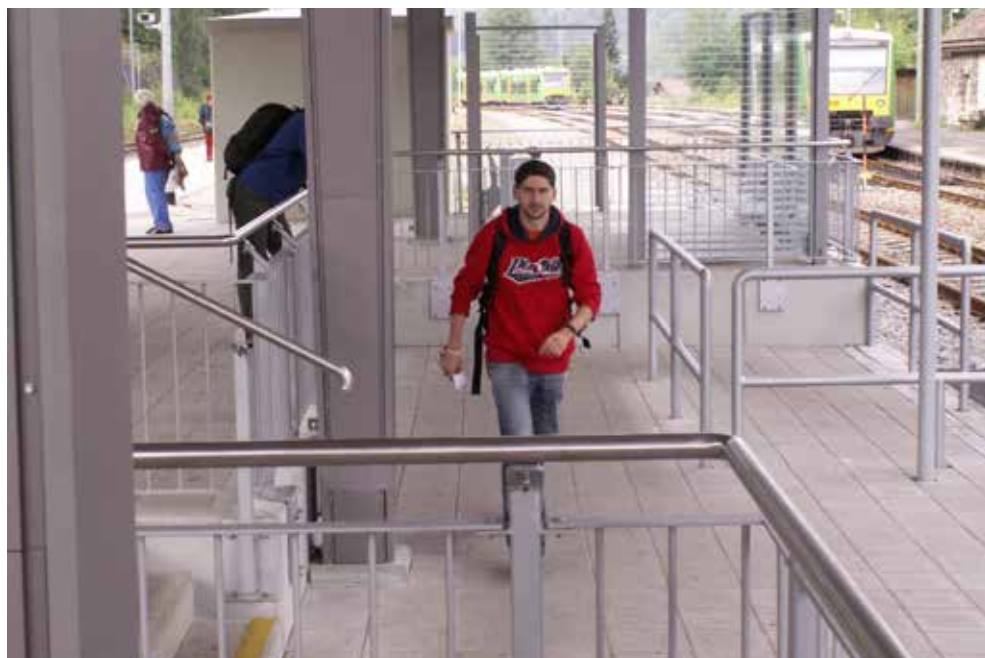
Foto6 – Žst. Zwiesel je dokladem možného řešení poloostrovního nástupiště s „šikanou“ u vstupu na centrální přechod, vybaveného funkčním a zároveň architektonicky zdařilým mobiliářem
