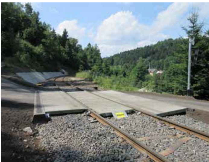
Obr. 5 – Přejezdová konstrukce BODAN se závěrnou zídkou RiBORD vlevo
