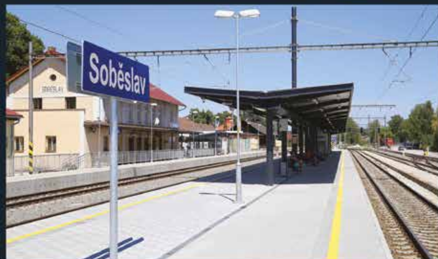
Rekonstrukce železniční stanice Soběslav
