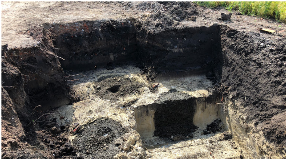
Obr. 5 – Ověření kompaktnosti nevíbrovaných štěrkových pilířů na kopané sondě v hloubce 2,0m (mimo dosah dynamické penetrace DP5 z obr. 4). Pilíř je celistvý, dostatečně ztuhlý. Kopaná sonda dále zobrazuje oblast zlepšení štěrkovými pilíři v organických zeminách, které tvoří podloží náspu tělesa železničního spodku a kontakt s horninovým podloží slánovců.
