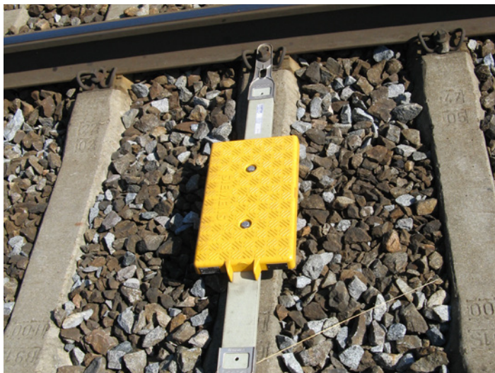
Obr. 6 Vortok Vossloh - pod šrouby – rychlejší instalace, není nutno vždy demontovat při podbíjení.
