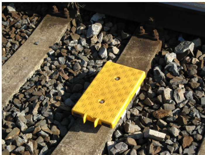
Obr. 5 Pásky – pomalá instalace, nutnost výluk, časem dochází k povolování – neosvědčilo se.
