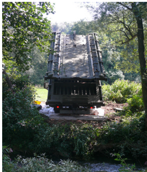
Obr.2 Montáž stožáru s využitím mobilního mostu ve funkci příjezdové komunikace
