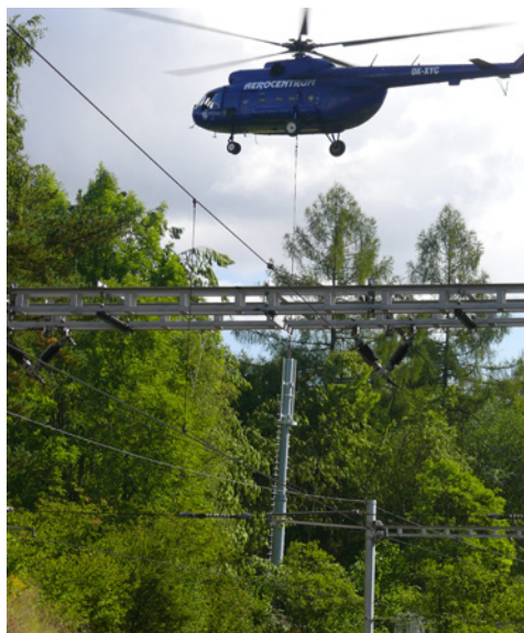
Obr.3 Montáž stožáru s využitím vrtulníku
