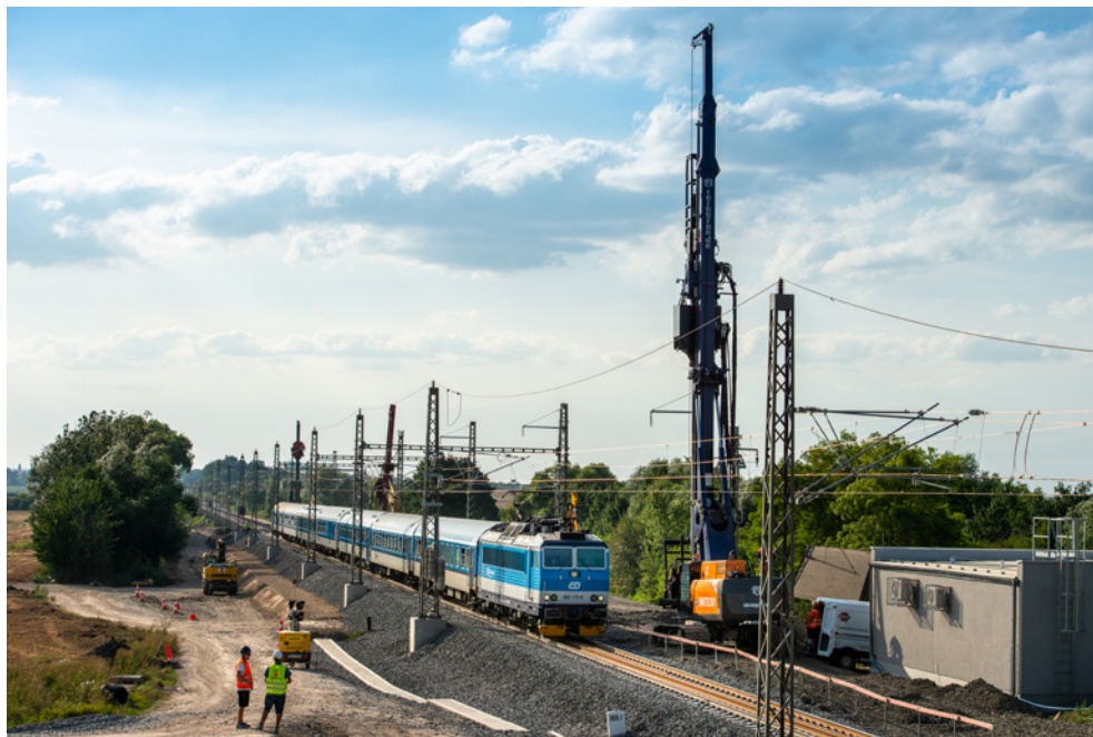
Obr. 1 – Těžká sanace nevibrovanými štěrkovými pilíři v koleji č.2: Odbočka Cerhenice
