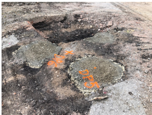
Obr. 3 – Dyn. penetrace DP5 v pilíři hl. 4m
