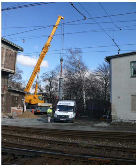
Obr.1 Montáž stožáru jeřábem
