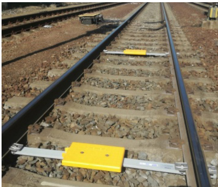
Obr. 7 Vortok Clamp - pod patu kolejnice – nejrychlejší instalace, nutno demontovat při podbíjení.
