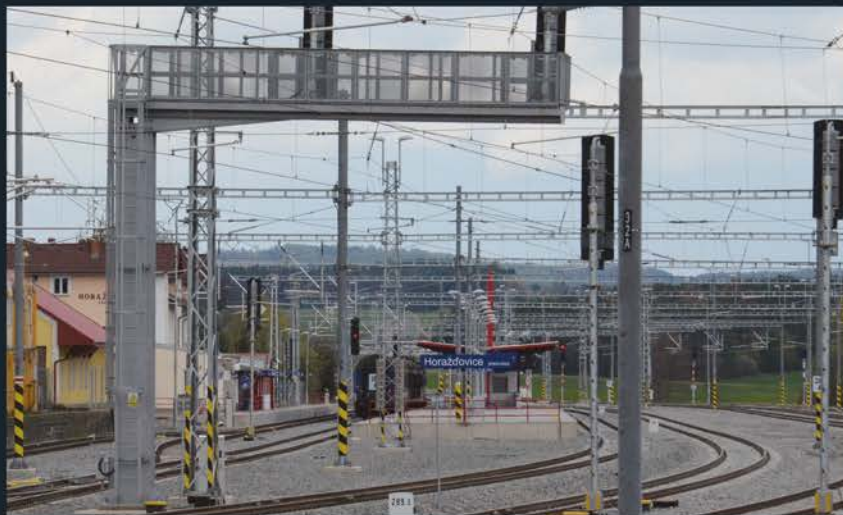
Rekonstrukce železniční stanice Horažovice předměstí
