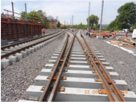
Obr. 2 – Žst. Chodov, novosedelské zhlaví, vlevo patrná budoucí rampa z podchodu na nástupiště č. 2
