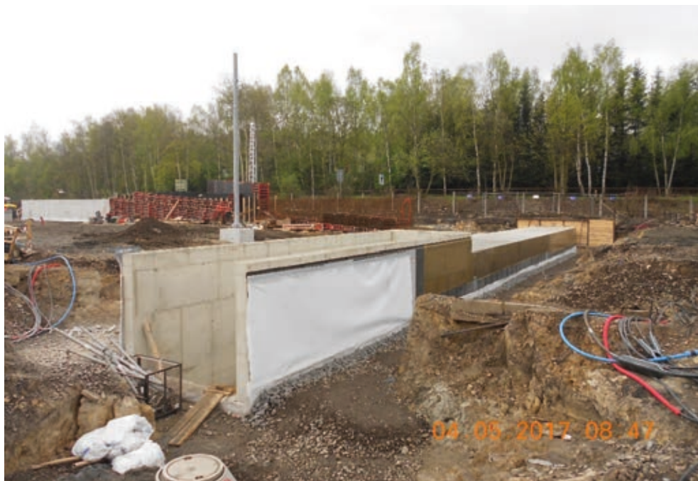
Obr. 1 – Žst. Chodov, podchod na zhlaví
